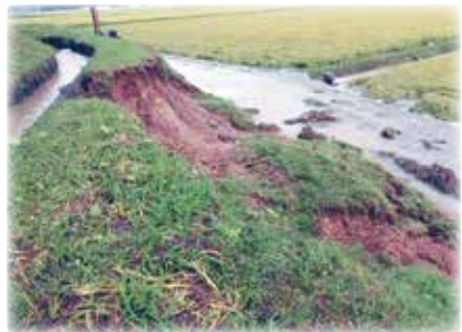
岩淵用水路法面崩落 【栗駒猿飛来久保冲 地内】
