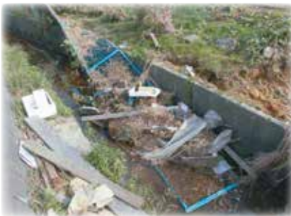
旧三の堰用水路ネットフェンス倒伏 【鷲沢袋 地内】
