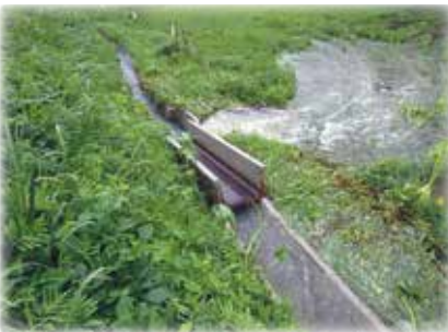
小用水路浮き上がり 【一迫柳目 地内】
