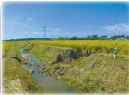
排水路法面崩落 【金成金生 地内】
