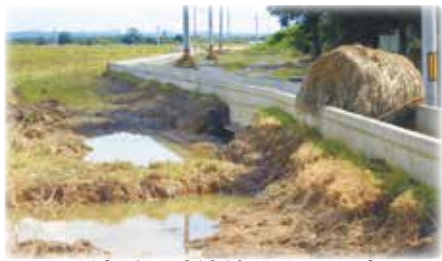
二迫川堤防決壊による冠水 【築館富冲富 地内】
