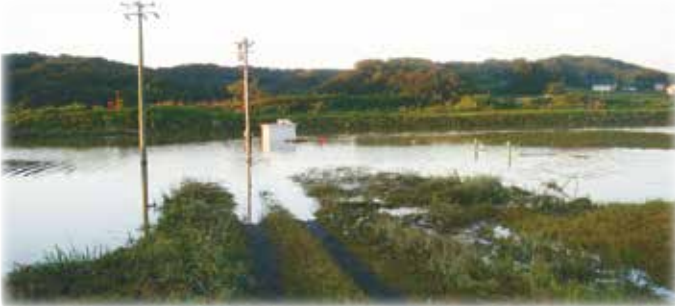
渡丸揚水機場水没 【栗駒渡丸 地内】
