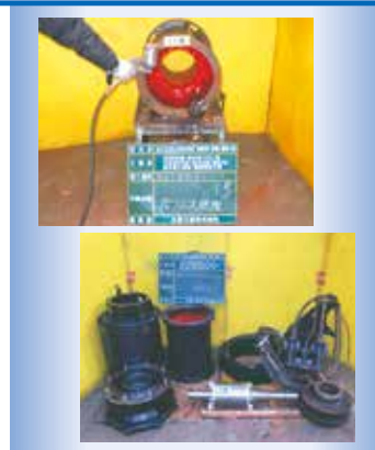
渡丸揚水機場整備補修工事
