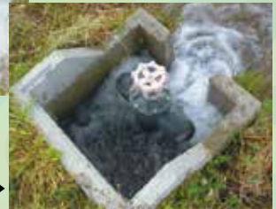
▶▶ ゴミ詰まり解消 ▶▶
