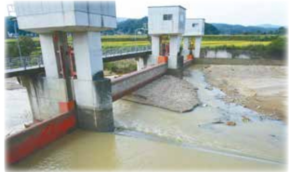
一の堰頭首工土砂堆積 【栗駒文字 地内】
