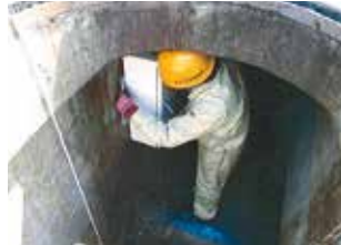
変換器取付状況
